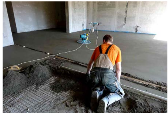
Рис. 12. Влаштування ц/п стяжки по матеріалу «Ізолкап» (полістиролбетон із заповнювачем «Політерм»)
