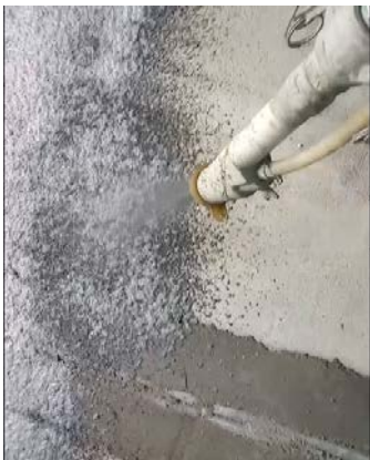
Рис. 10. Процес напilenня матеріалу “Gum Gum Spray”
