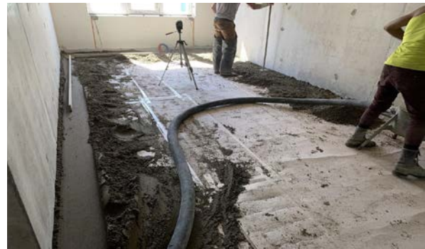
Рис. 5. Влаштування ц/п стяжки по матеріалу «Акуфлекс»
