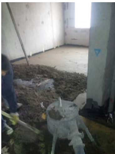
Рис. 11. Влаштування ц/п стяжки по матеріалу “Gum Gum Spray”
