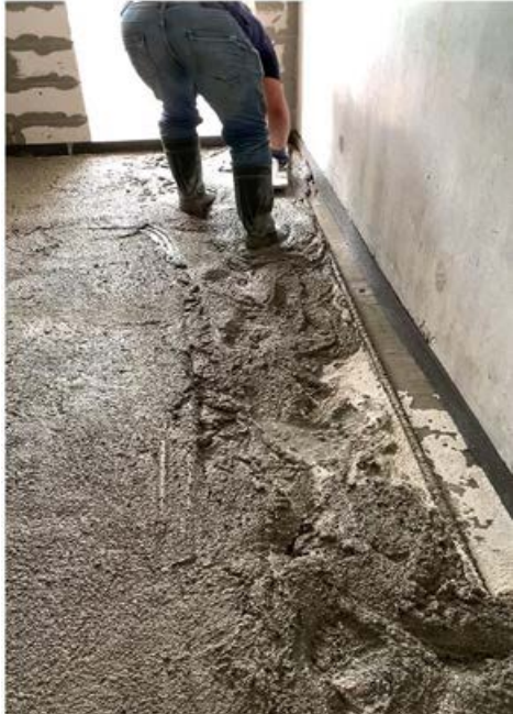
Рис. 3. Влаштування матеріалу «Ізолкап» (полістиролбетон із заповнювачем «Політерм»)/«Ізолкап Fine» (полістиролбетон із заповнювачем «Політерм Fine»)
