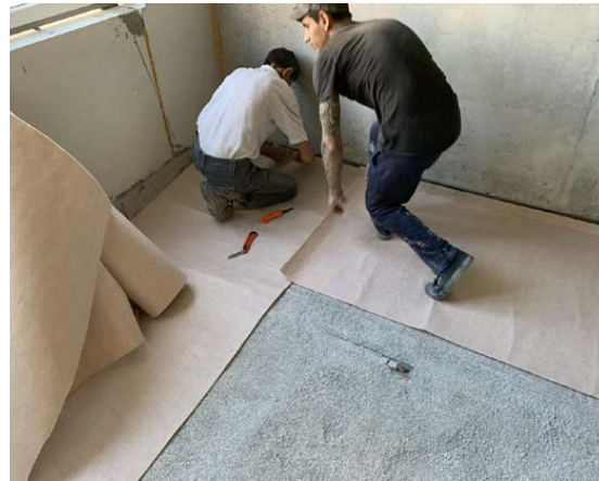
Рис. 4. Влаштування матеріалу «Акуфлекс»
