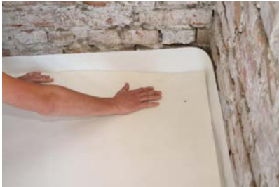
Рис. 9. Укладка матеріалу “Izolon Base”
