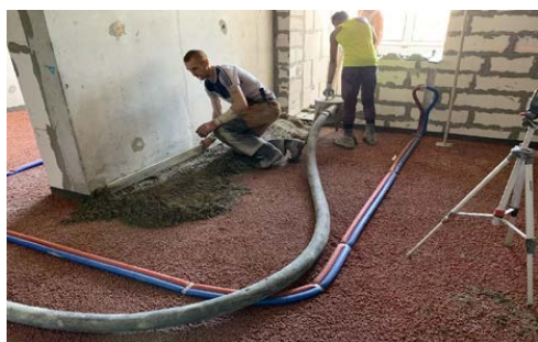
Рис. 7. Влаштування ц/п стяжки по матеріалу «Пінополістирольні гранули на жорсткому в'язкому»
