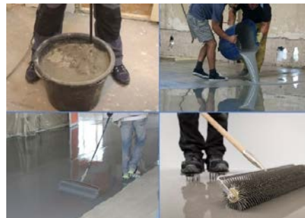
Рис. 8. Процес влаштування самовирівнюючої стяжки «Ceresit CN-69»
