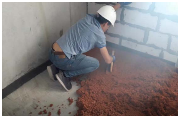
Рис. 6. Процес влаштування матеріалу «Пінополістирольні гранули на жорсткому в'язкому»
